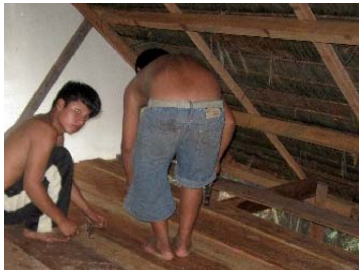
Construyendo el albergue - Colorado
