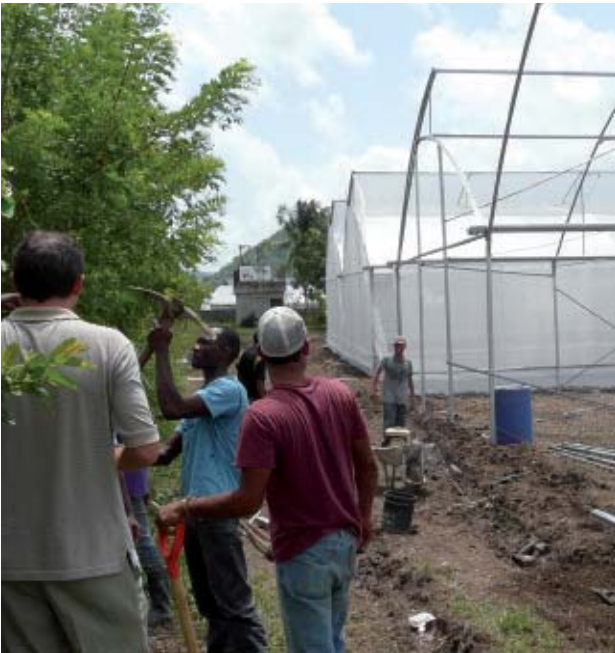
Construcción de los invernaderos
